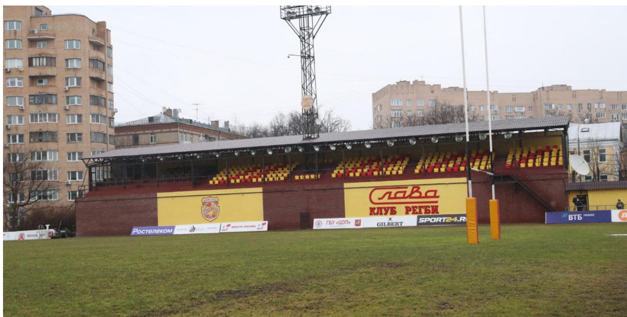
Стадион «Слава» после реконструкции 2019-20 годов.
